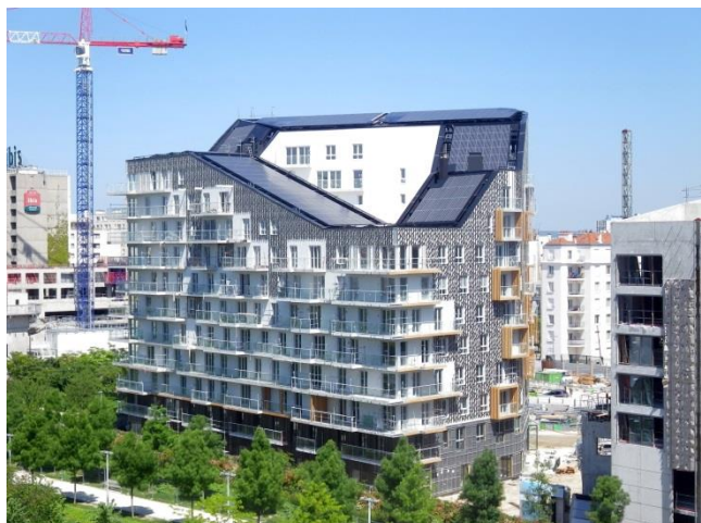
Toiture de l'immeuble Quintessence, ZAC Clichy-Batignolles, 2012
